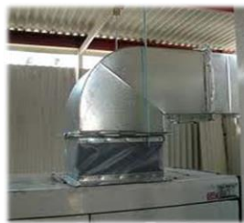
排気用ダクトを接続して、断熱する
